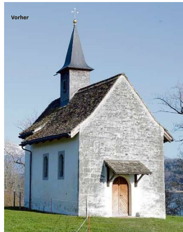
Kapelle vor und nach der Restaurierung.
